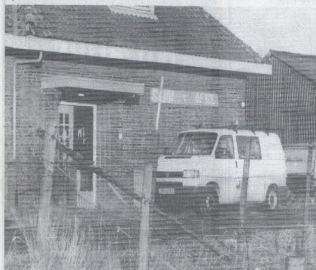
Het S.L.I.M. gebouw aan de Tol dat inmiddels voor 700.000 gulden verkocht is aan Rijkswaterstaat. Het busje is van een installateur.
